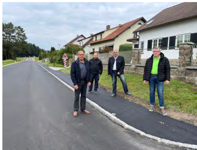
Gehsteigerweiterung in Alt-Nägelberg
